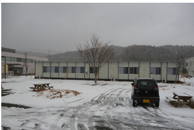
仮設開成拠点センターの駐車場もすっかり雪景色だ。気候穏やかな宮城県石巻も雪国であることを実感する。
